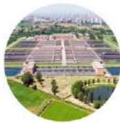
Depuratore di Nosedo
